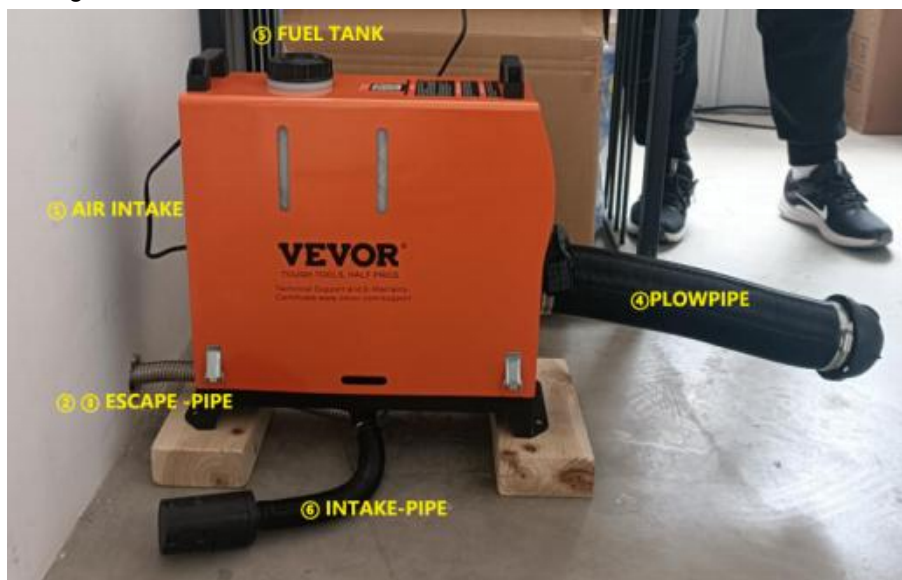
Försiktighetsåtgärder för installationsplatsen - schematiskt diagram
