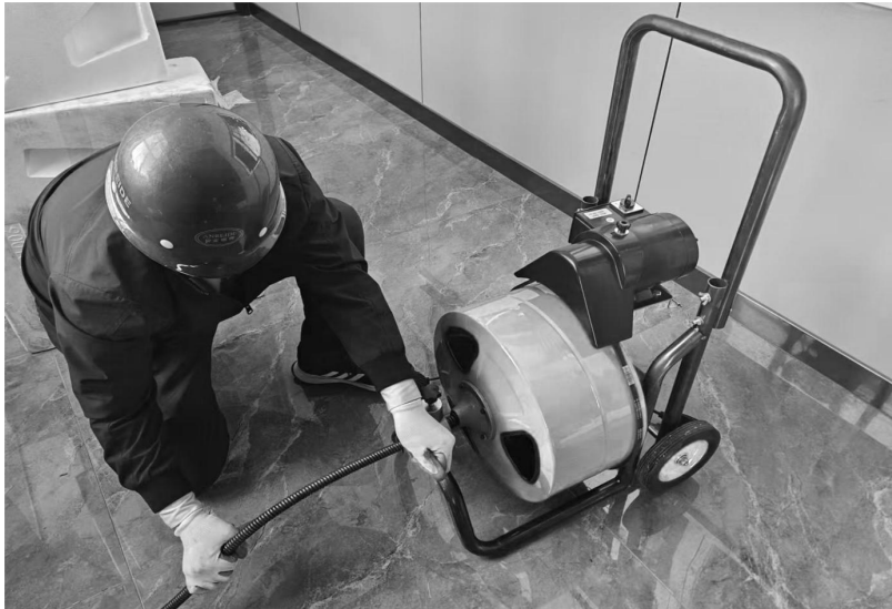
Abbildung – Beispiel für die korrekte Arbeitshaltung
